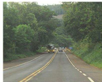
RODOVIA DE PISTA SIMPLES
