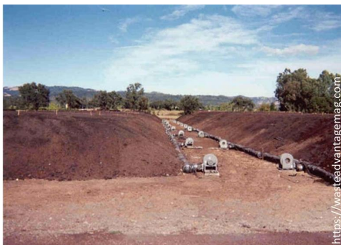
Leiras sendo aeradas por injeção de ar.
