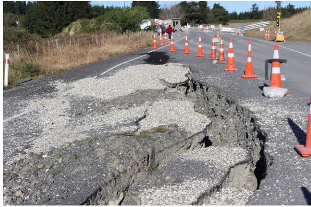
Figura 43: Exemplo de solo colapsível sob pavimento
