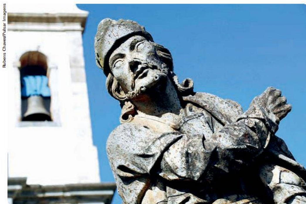
Obra de Aleijadinho prejudicada pela chuva ácida em Congonhas (MG), em 2011.
