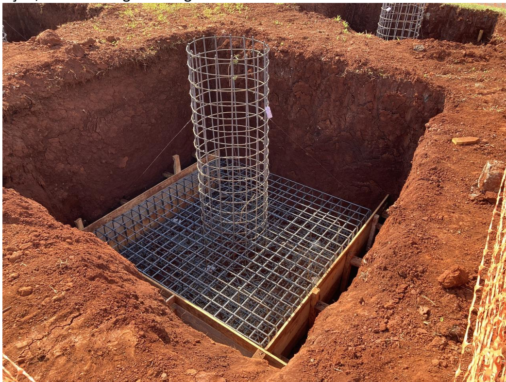
Figura 19: sapata a ser concretada, observe a proximidade do solo no caso da sapata
