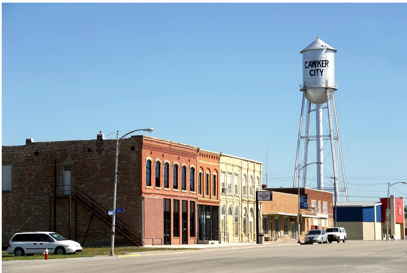
Figura 37: a NBR 6118 permite diferentes abordagens sobre a consideração da ação da água em uma estrutura. O exemplo clássico é os reservatórios, que podem possuir cargas de alto valor e com natureza de ação permanente ou variável
