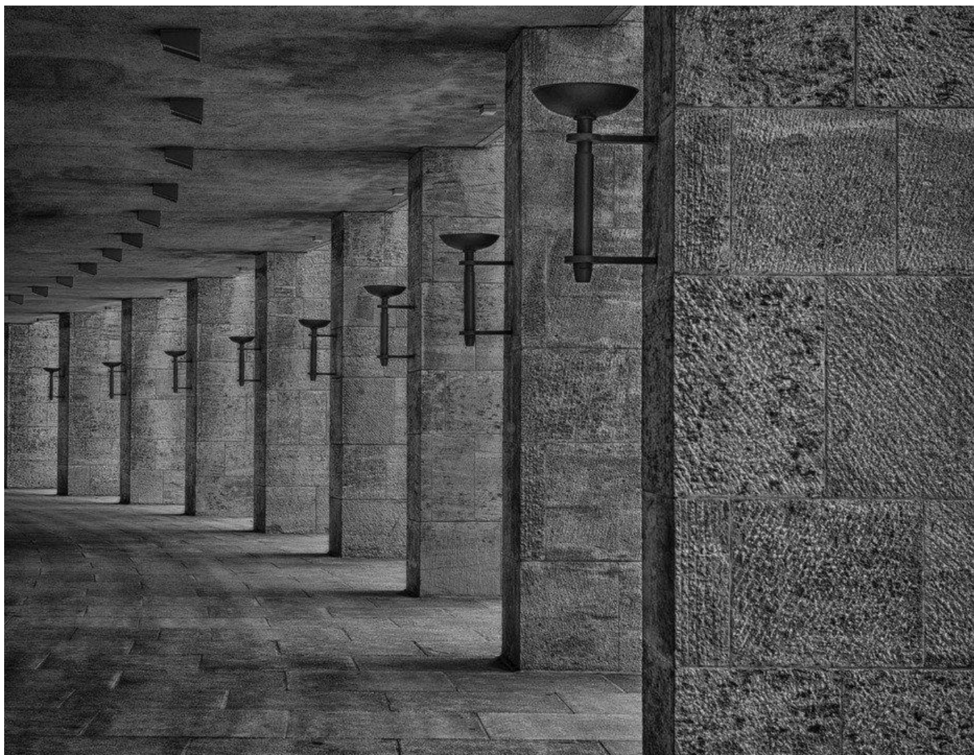
Figura 6: exemplo de pilares-parede
