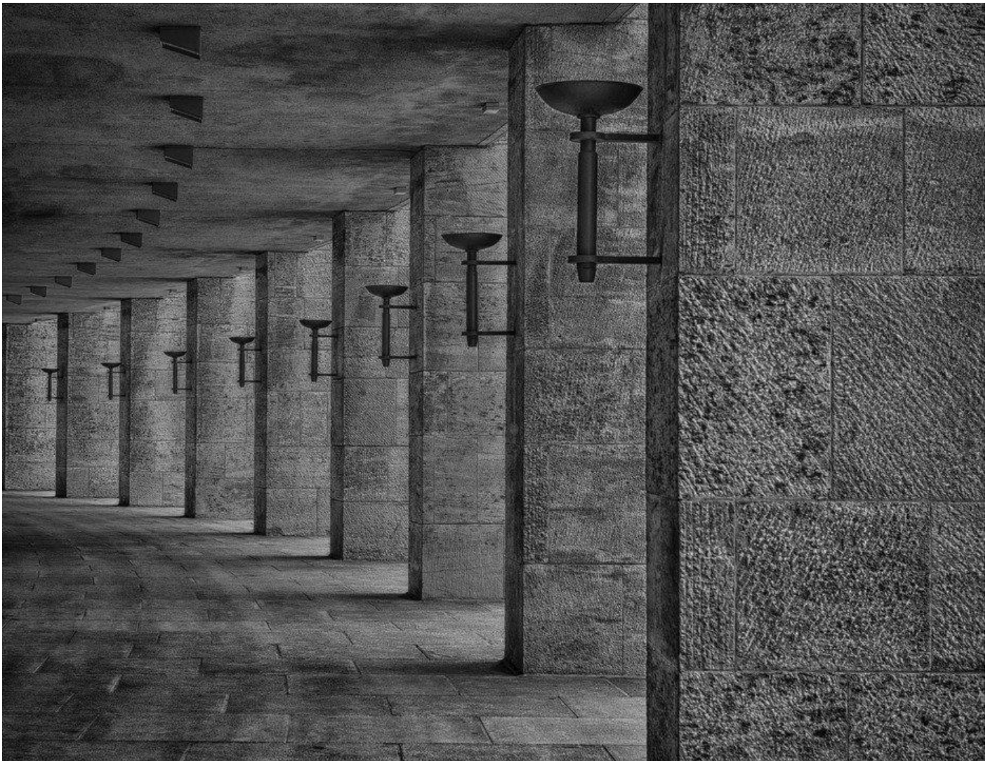
Figura 6: exemplo de pilares-parede
