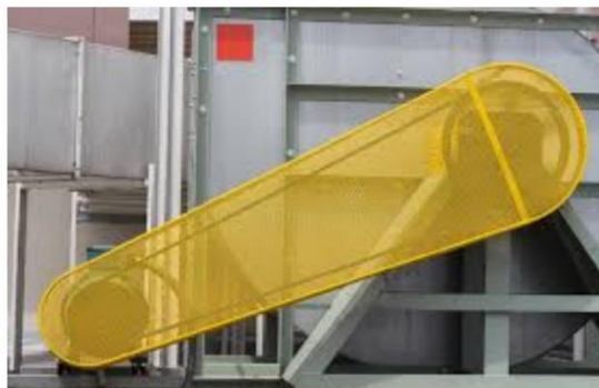
Figura 1.2: Sistema de transmissão de potência com proteção 2
