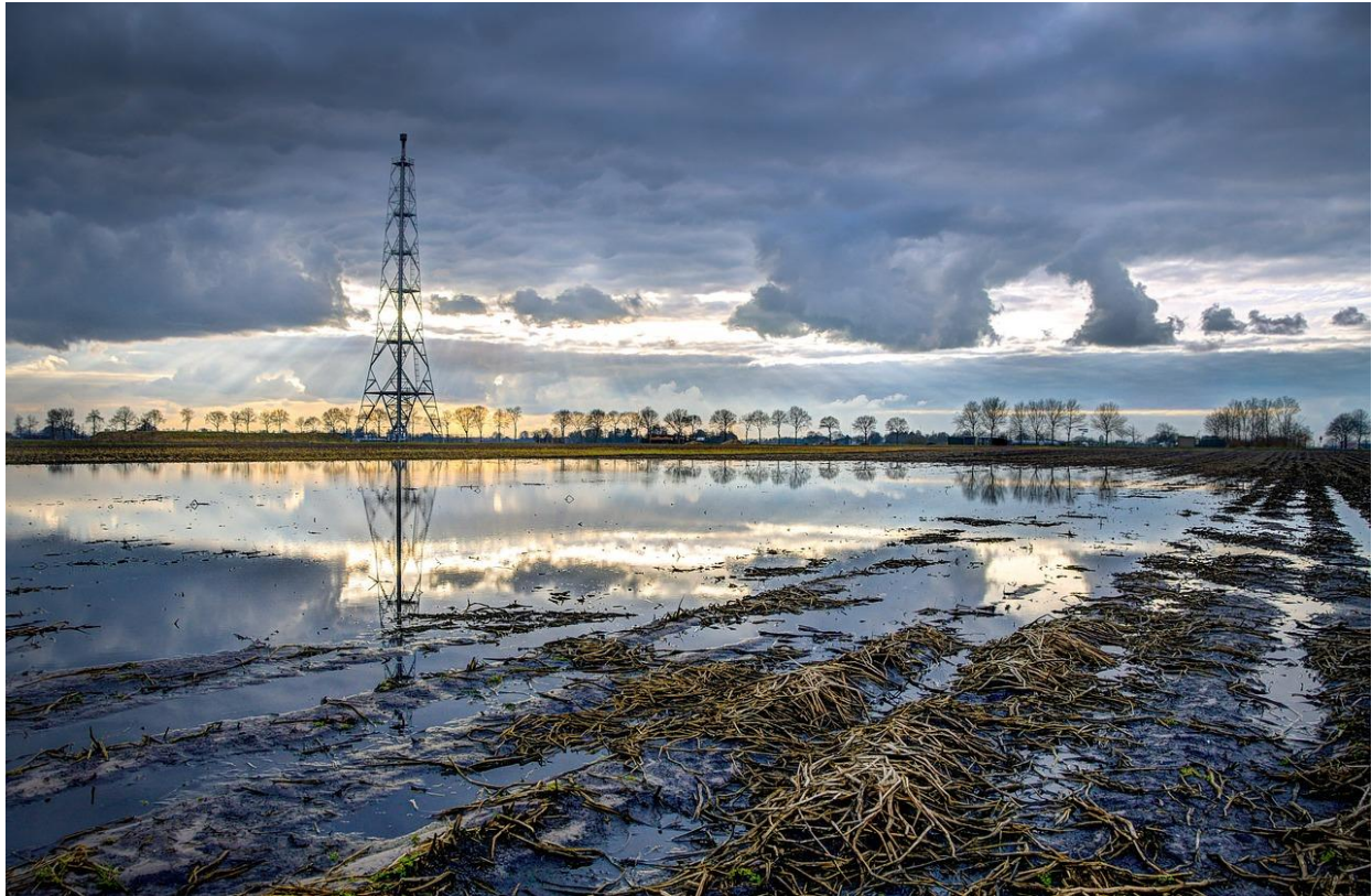
Figura 16: local que necessita de drenagem prévia para a execução de aterro que receberá futura rodovia
