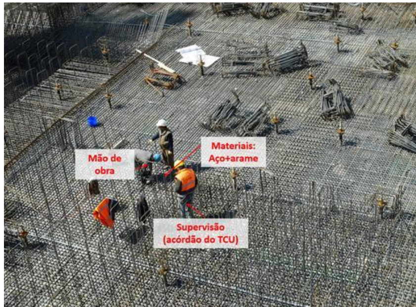
Figura 7: abertura de uma composição de serviço de armação nos seus diversos insumos
