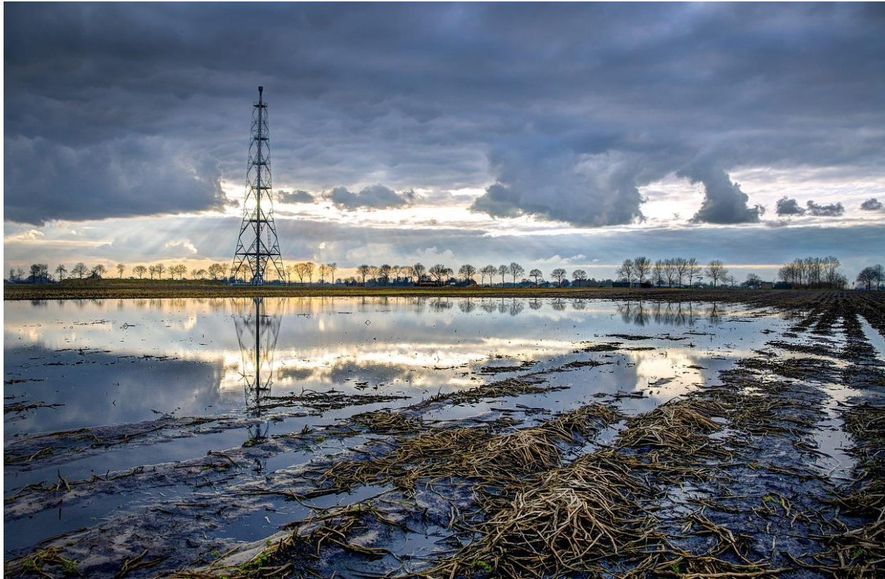
Figura 16: local que necessita de drenagem prévia para a execução de aterro que receberá futura rodovia
