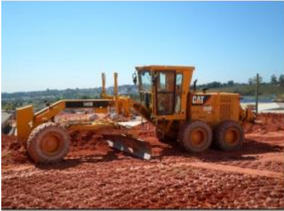
Figura 9: o SINAPI faz medições in loco sobre o desempenho dos equipamentos, não se pautando por manuais técnicos do fabricante
