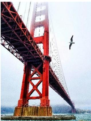
As **treliças planas** são basicamente formadas por **elementos delgados unidos** em suas extremidades. Alguns exemplos de treliças são: pontes (ao lado), tesouras de telhados, guindastes (gruas), entre outros. Diversos materiais podem ser utilizados para a montagem de treliças, dentre eles destacam-se madeira e metais, sendo que a união dos pontos nas extremidades (nós) dos elementos podem ser via soldagem, rebites, pinos ou parafusos.
