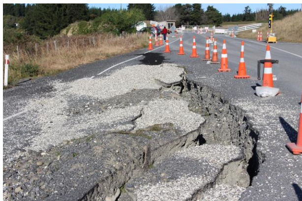
Figura 43: Exemplo de solo colapsível sob pavimento
