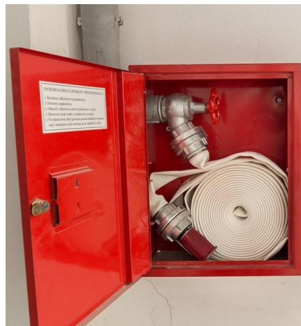
Hidrante (sist. tipo 2 ou 3)
