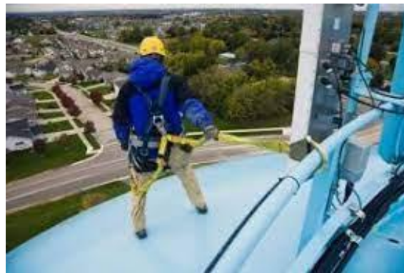
Figura 1.22: uso de cinturão de segurança com talabarte para posicionamento (restrição de movimentação) do trabalhador em altura.
