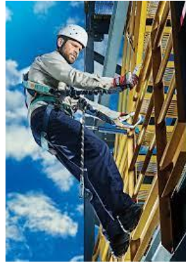
Figura 1.21: uso de cinturão de segurança com talabarte para proteção contra quedas.
