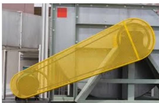
Figura 1.2: Sistema de transmissão de potência com proteção 2
