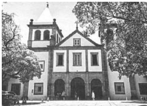
A) Mosteiro de São Bento (RJ)
