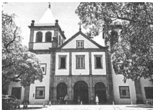
A) Mosteiro de São Bento (RJ)
