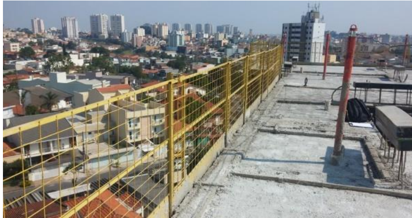
Figura 1.3: Utilização de guarda-corpo como SPQC em uma obra de construção civil, eliminando completamente o risco de queda de altura do pavimento superior.
