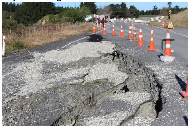
Figura 36: Exemplo de solo colapsível sob pavimento
