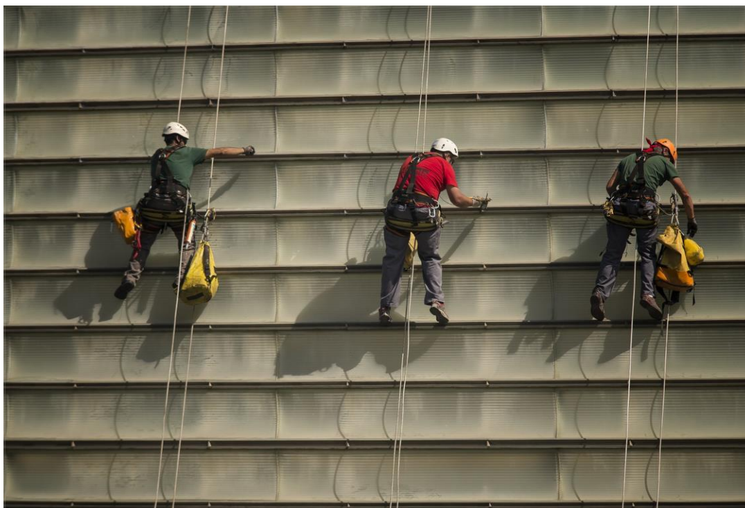
Figura 26: Atividade em altura utilizando cadeira suspensa
