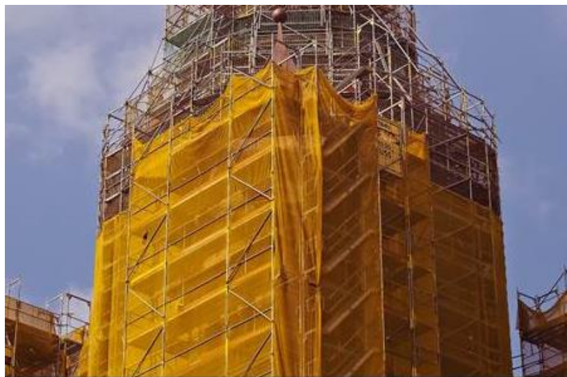
Figura 31: Telas de proteção contra projeção de materiais
