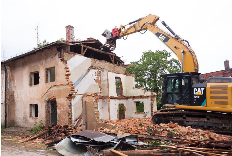
Figura 20: Edificação sendo demolida com auxílio de máquina.
