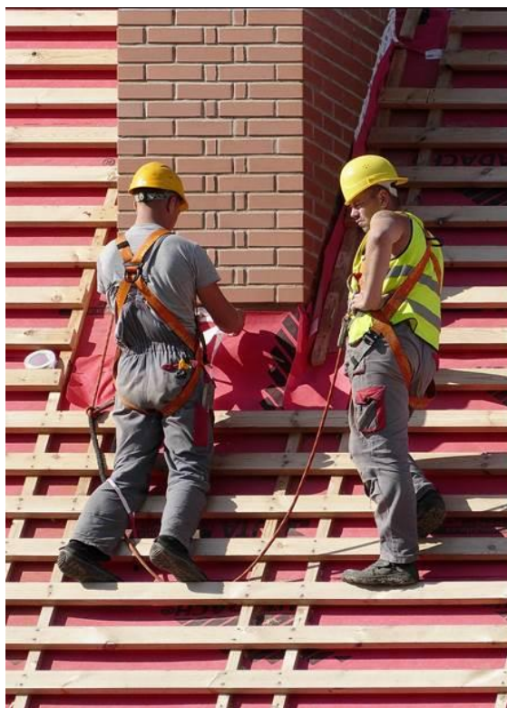
Figura 29: Trabalhadores com atividade em telhado utilizando sinto de segurança tipo paraquedista.
