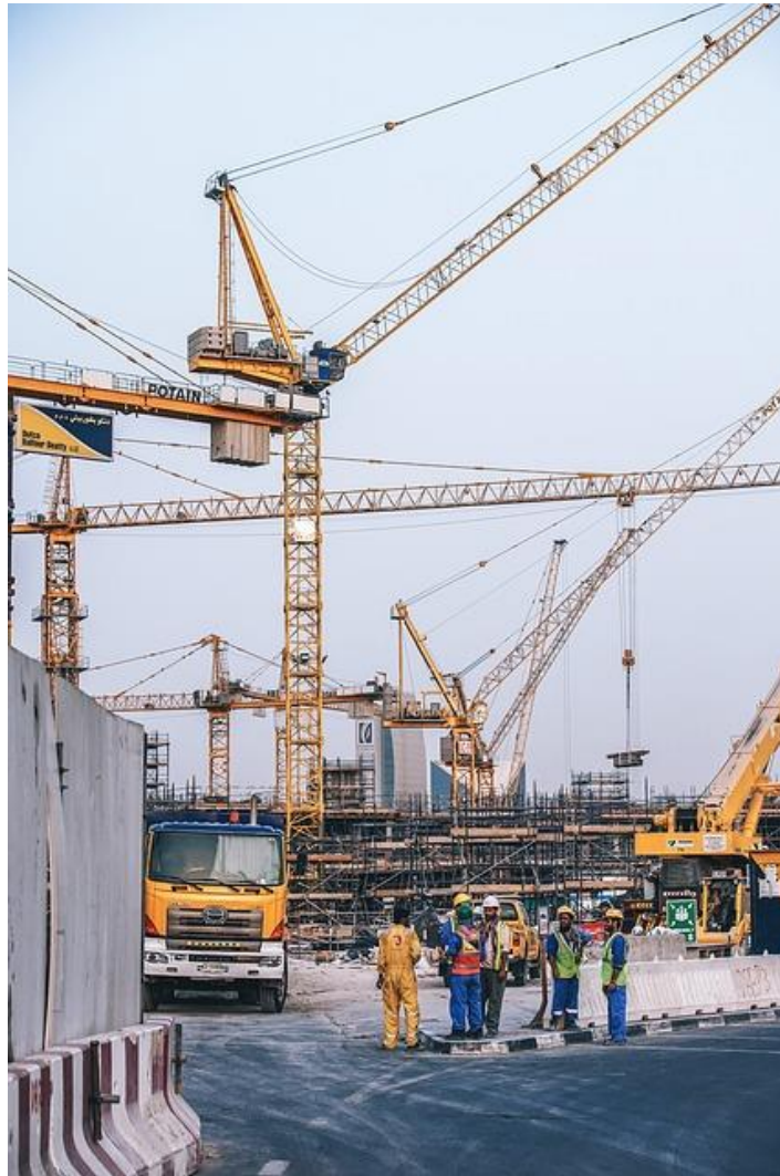
Figura 1: Trabalhadores em canteiro de obras
