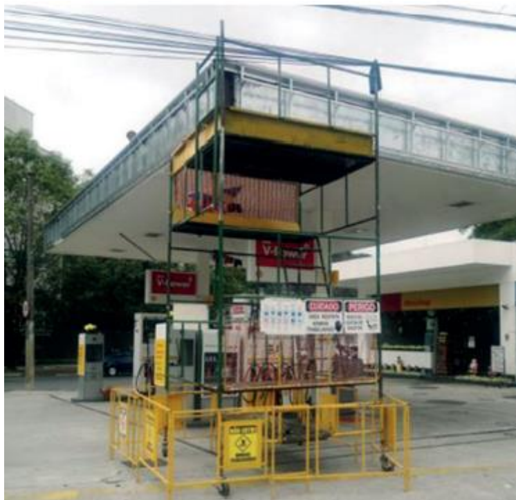
Figura 24: exemplo de um andaime instalado (BRASIL, 2013)
