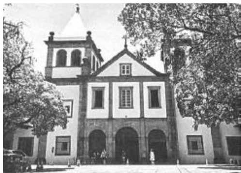
A) Mosteiro de São Bento (RJ)
