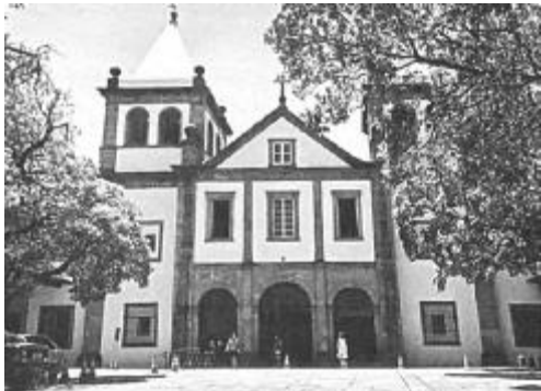
A) Mosteiro de São Bento (RJ)
