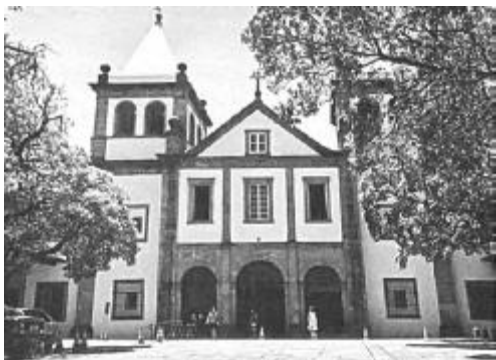
A) Mosteiro de São Bento (RJ)
