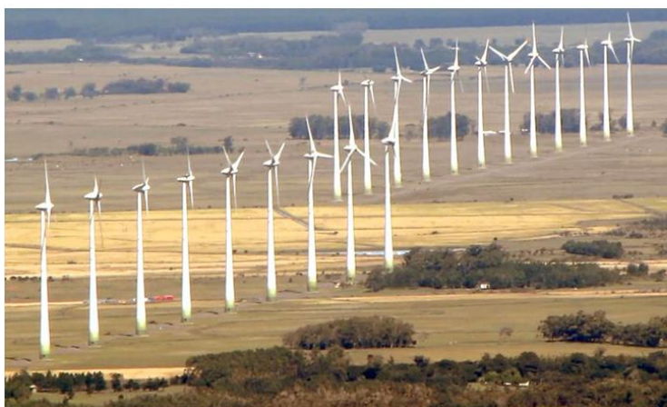
Parque eólico no Rio Grande do Sul.
