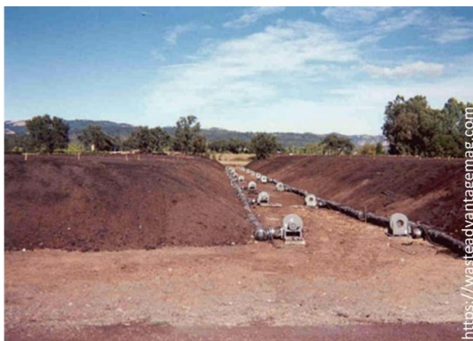
Leiras sendo aeradas por injeção de ar.
