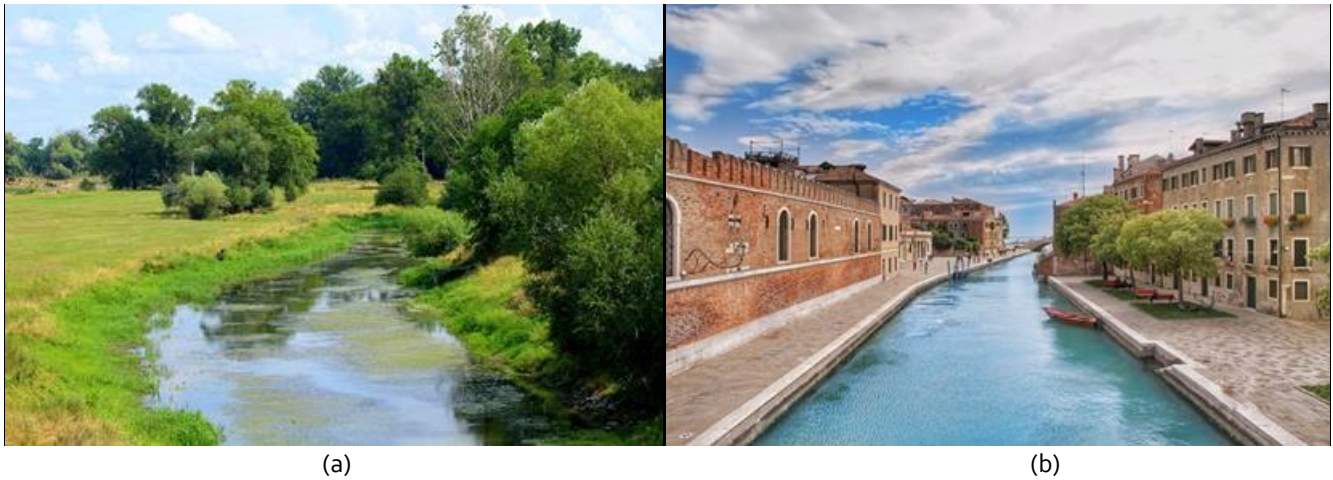
Figura 67: Intervenção na seção de canais: a) canal natural; b) canal com seção transversal alterada e revestimento de concreto
