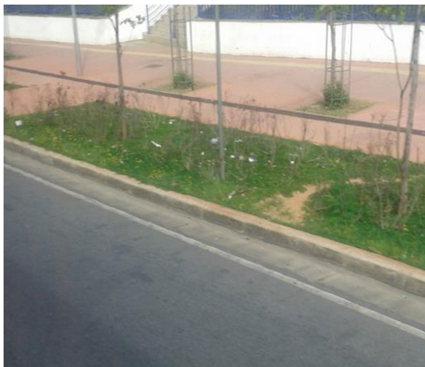
Figura 55: Sarjeta no encontro entre meio fio e via
