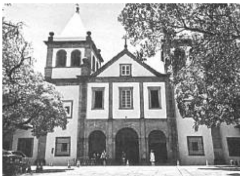
A) Mosteiro de São Bento (RJ)
