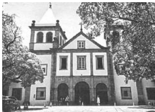
A) Mosteiro de São Bento (RJ)
