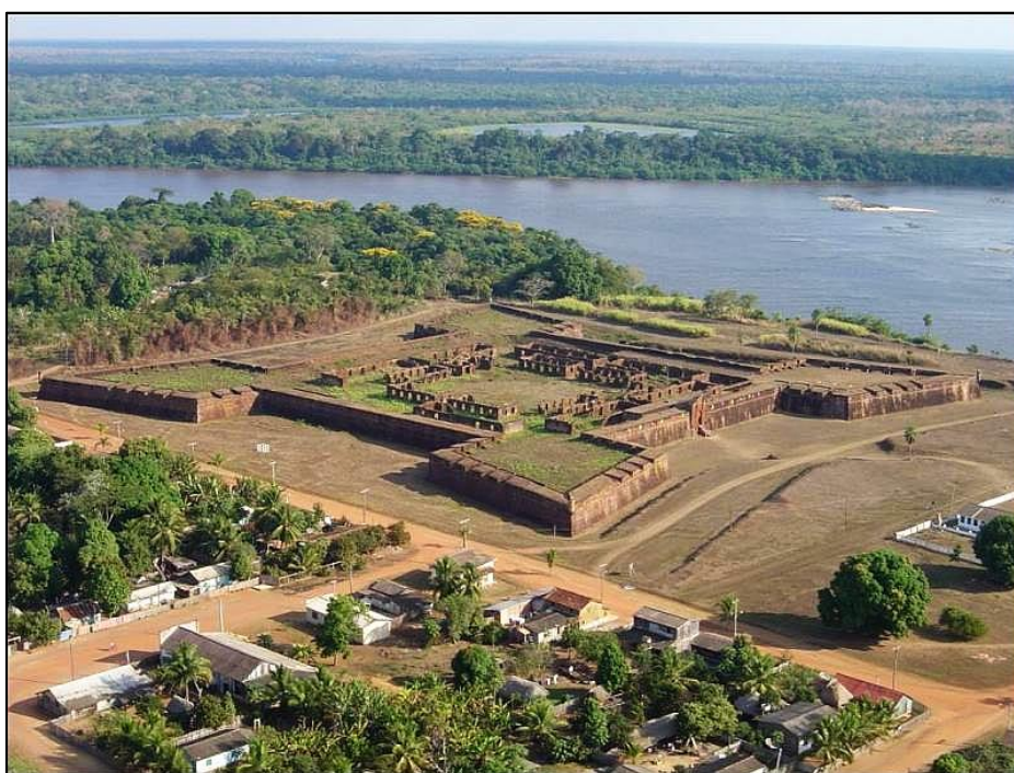
Vista do Real Forte do Príncipe da Beira, na margem direita do rio Guaporé.
