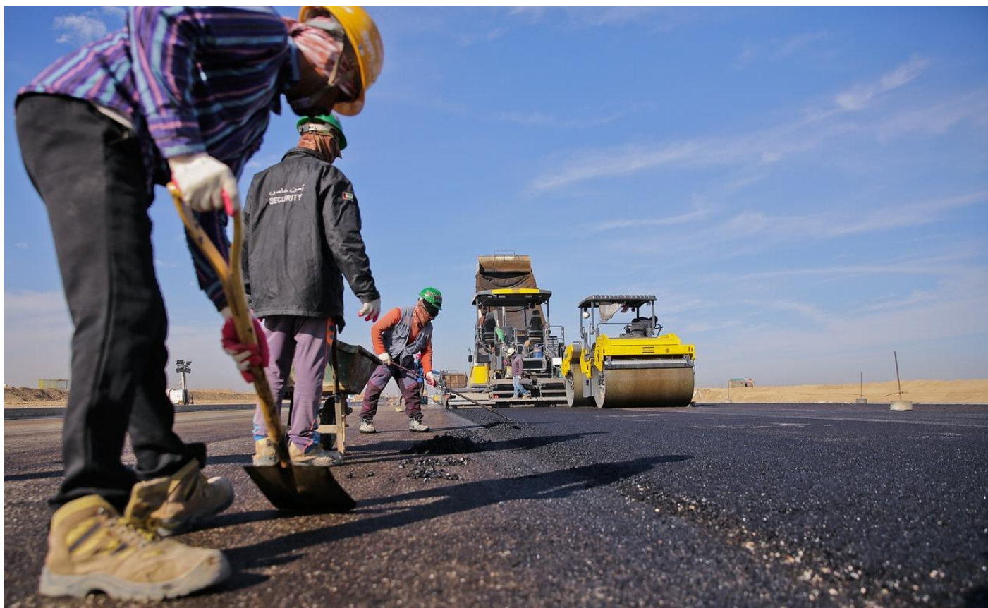
Figura 24: em obras rodoviárias é comum o transporte coletivo de trabalhadores, dadas as distâncias das frentes de obra ao canteiro
