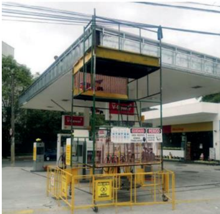
Figura 32: exemplo de um andaime instalado (BRASIL, 2013)
