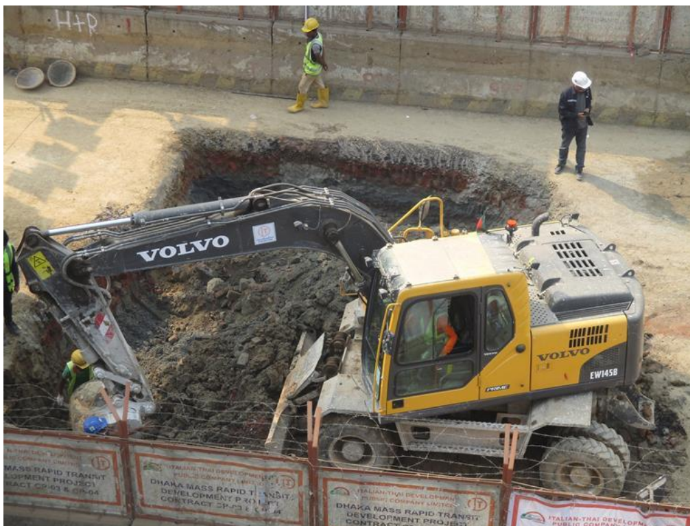
Figura 25: Escavação sendo iniciada em canteiro de obras
