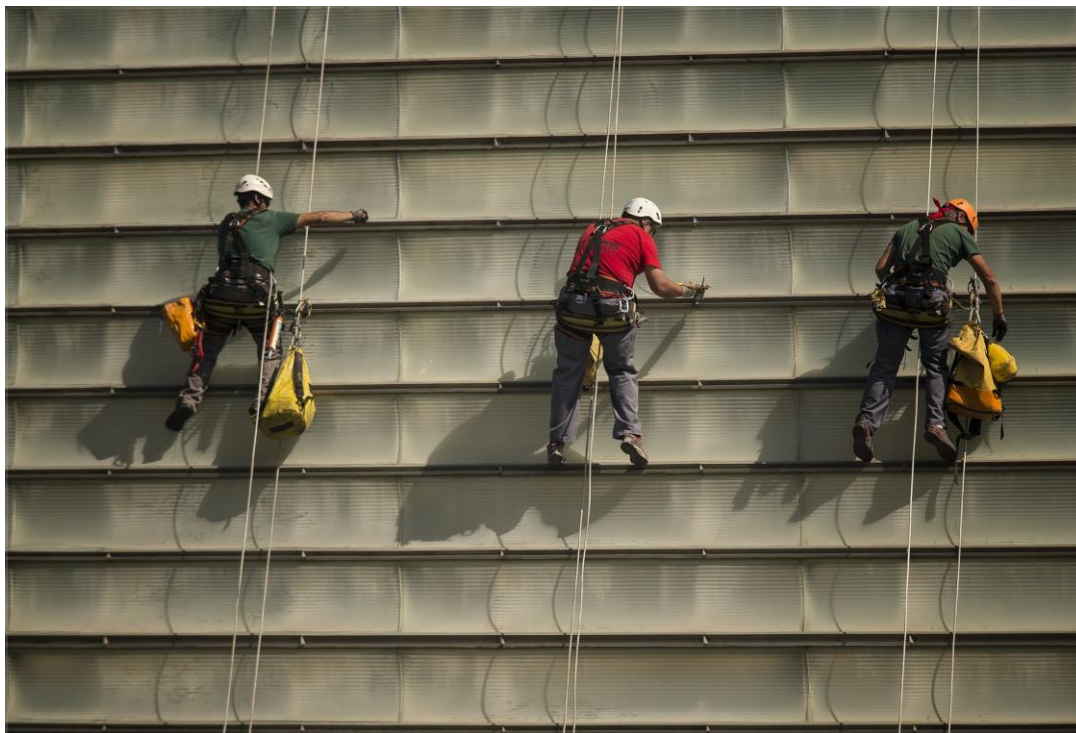
Figura 34: Atividade em altura utilizando cadeira suspensa
