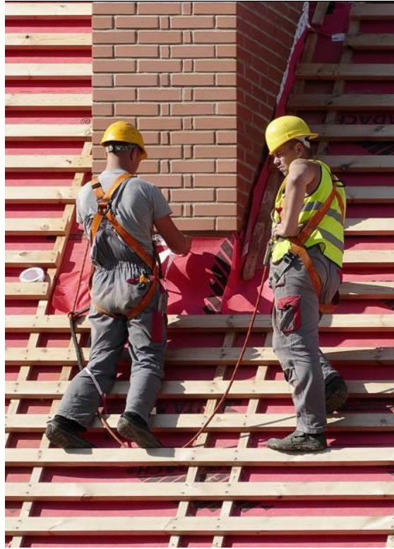
Figura 38: Trabalhadores com atividade em telhado utilizando sinto de segurança tipo paraquedista.
