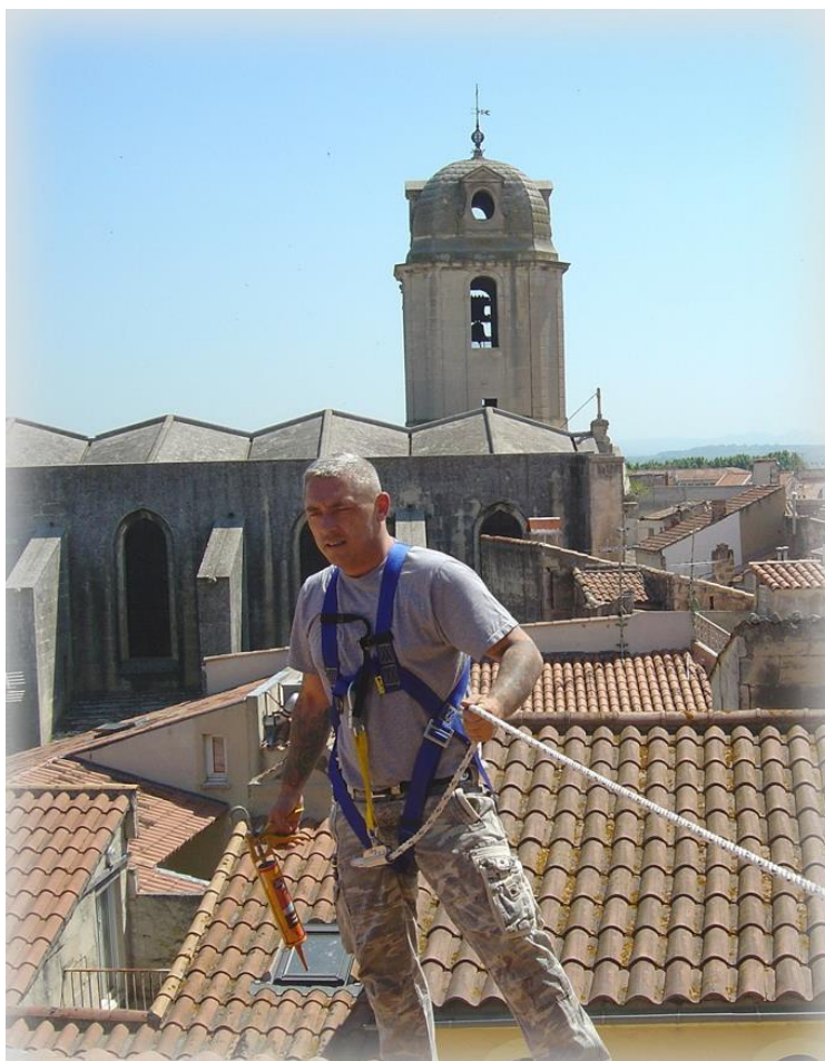
Figura 6: Trabalhador utilizando cinto de segurança tipo paraquedista segurando talabarte na mão
