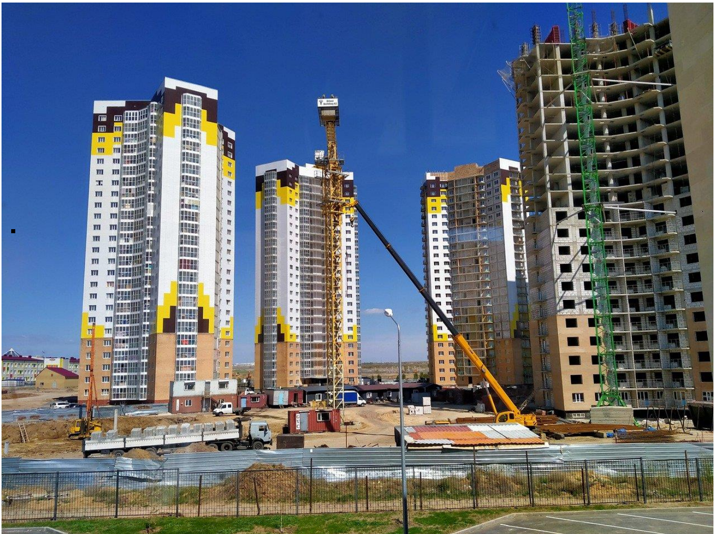
Figura 3: em obras de grande porte geralmente se tem maior espaço disponível para o canteiro, o que permite a instalação do tipo "amplo"
