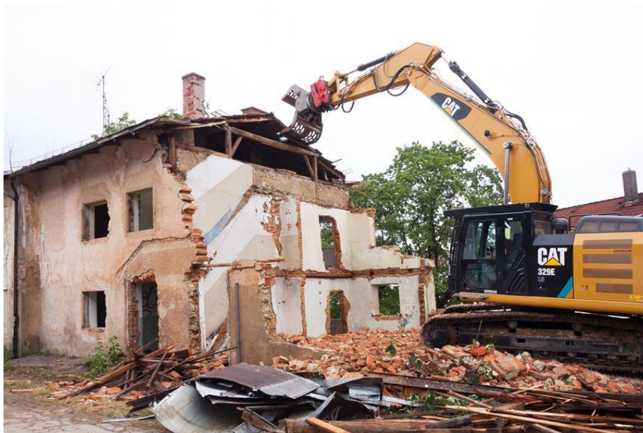
Figura 28: Edificação sendo demolida com auxílio de máquina.
