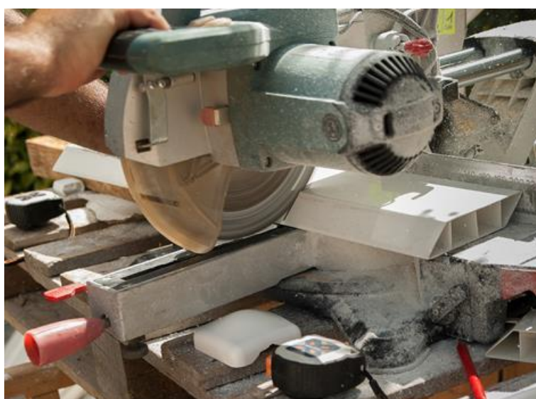
Figura 18: Serra circular em operação
