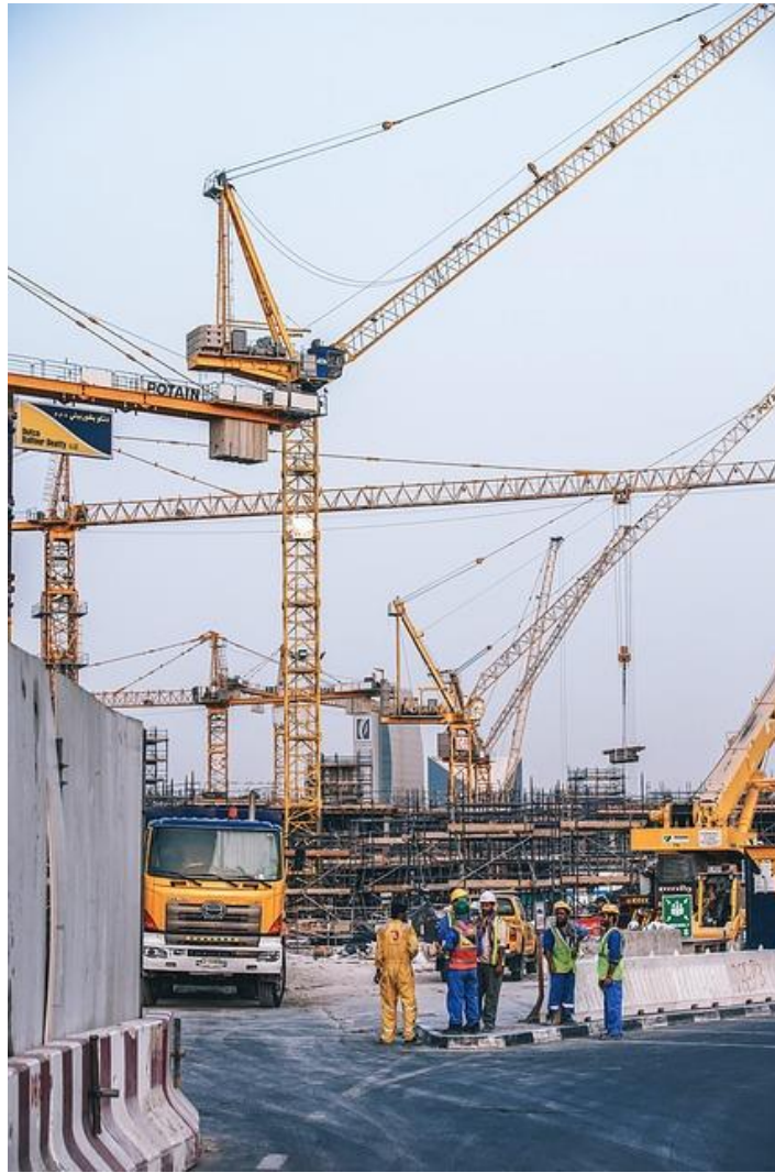
Figura 2: Trabalhadores em canteiro de obras
