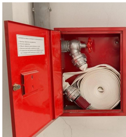
Hidrante (sist. tipo 2 ou 3)
