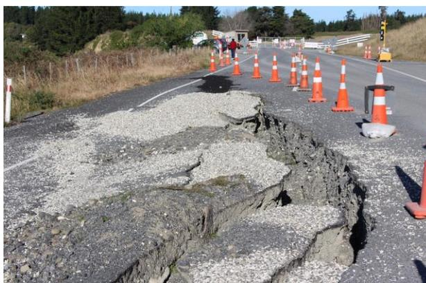
Figura 44: Exemplo de solo colapsível sob pavimento
