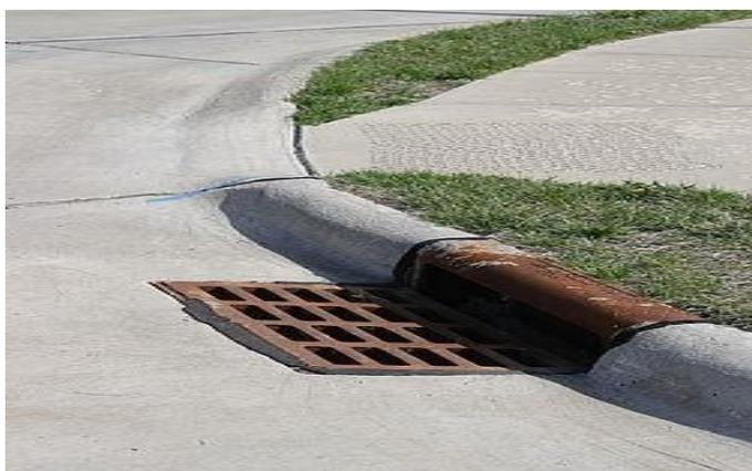
Meio-fio ou calçamento, com canalização de águas pluviais.
