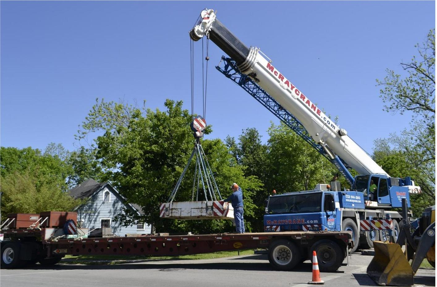
*Figura 32: o içamento de peças deve ser pensado na fes de projetos, devido aos esforços criados na peça, muitas vezes em configuração diferente daquela que a peça sofrerá durante a vida da estrutura.*
