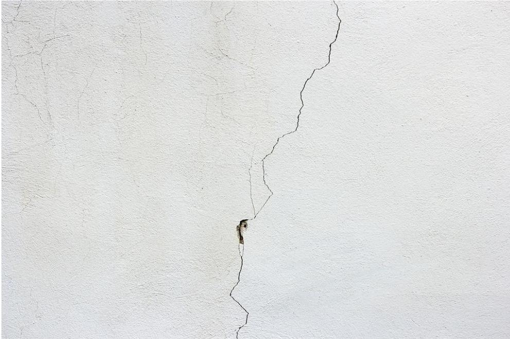
Figura 41: nem sempre uma trinca no concreto indica ruptura da estrutura por tração
