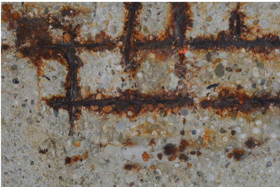
Figura 18: a falta de cobertura da armadura prejudica a vida útil da estrutura
