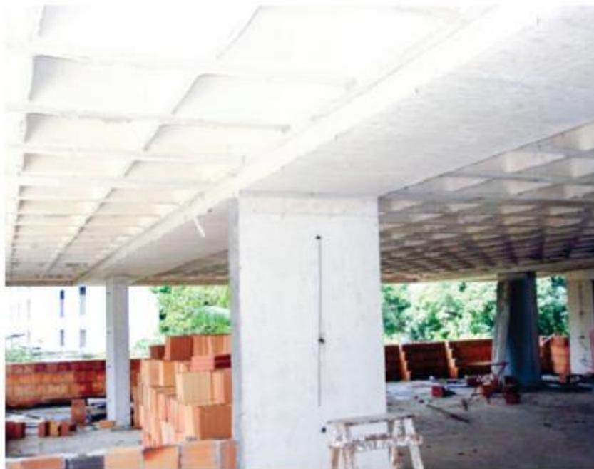
*Figura 9: viga-faixa em laje nervurada, utilizada principalmente para conferir rigidez à laje quando se quer vencer grandes vãos<sup>1</sup>*
