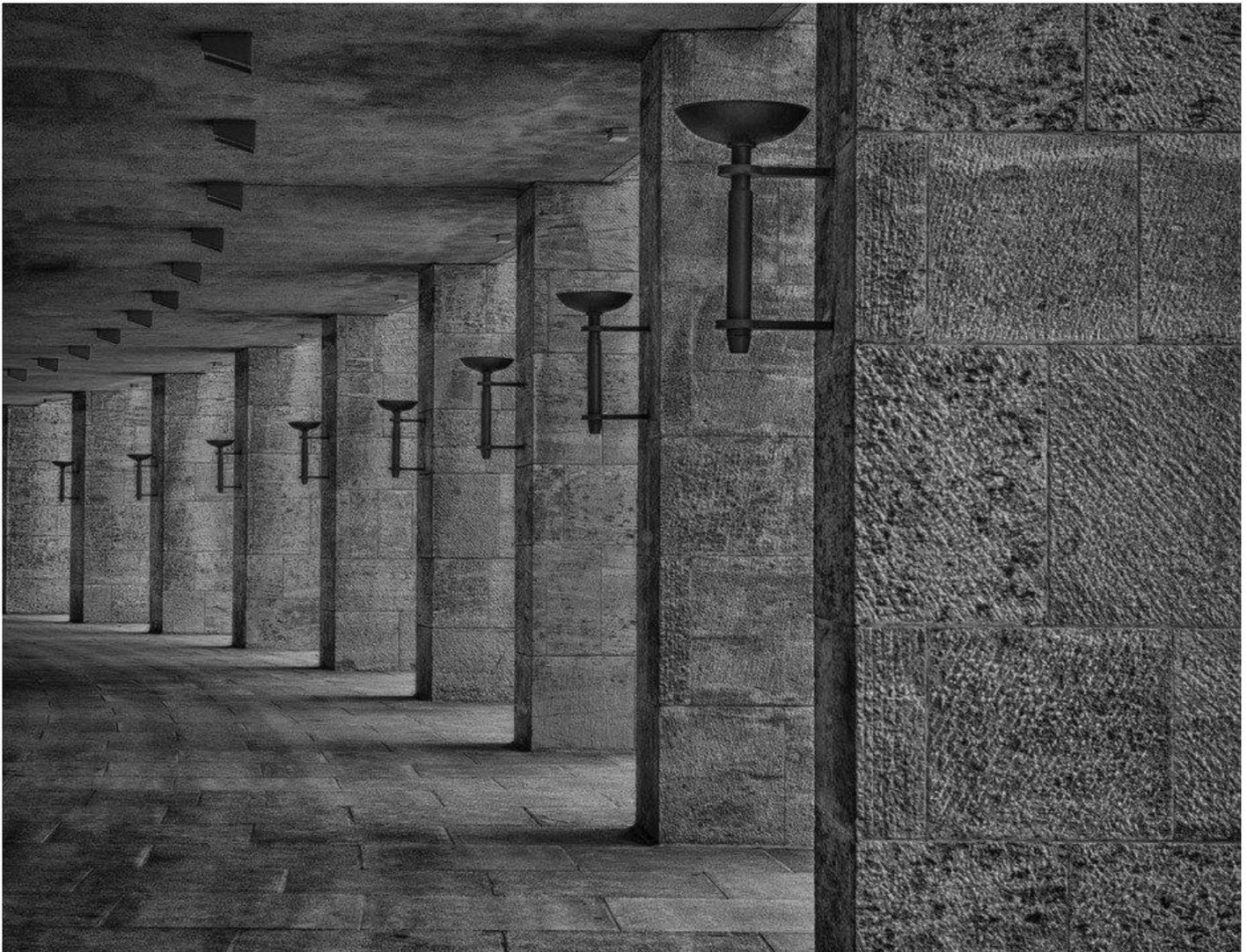
*Figura 6: exemplo de pilares-parede*
