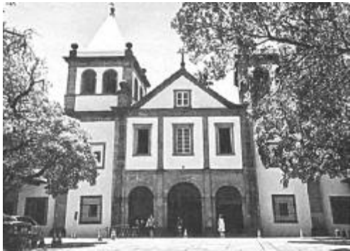
A) Mosteiro de São Bento (RJ)
