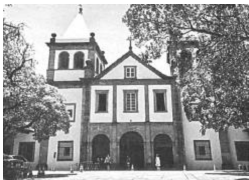
A) Mosteiro de São Bento (RJ)
