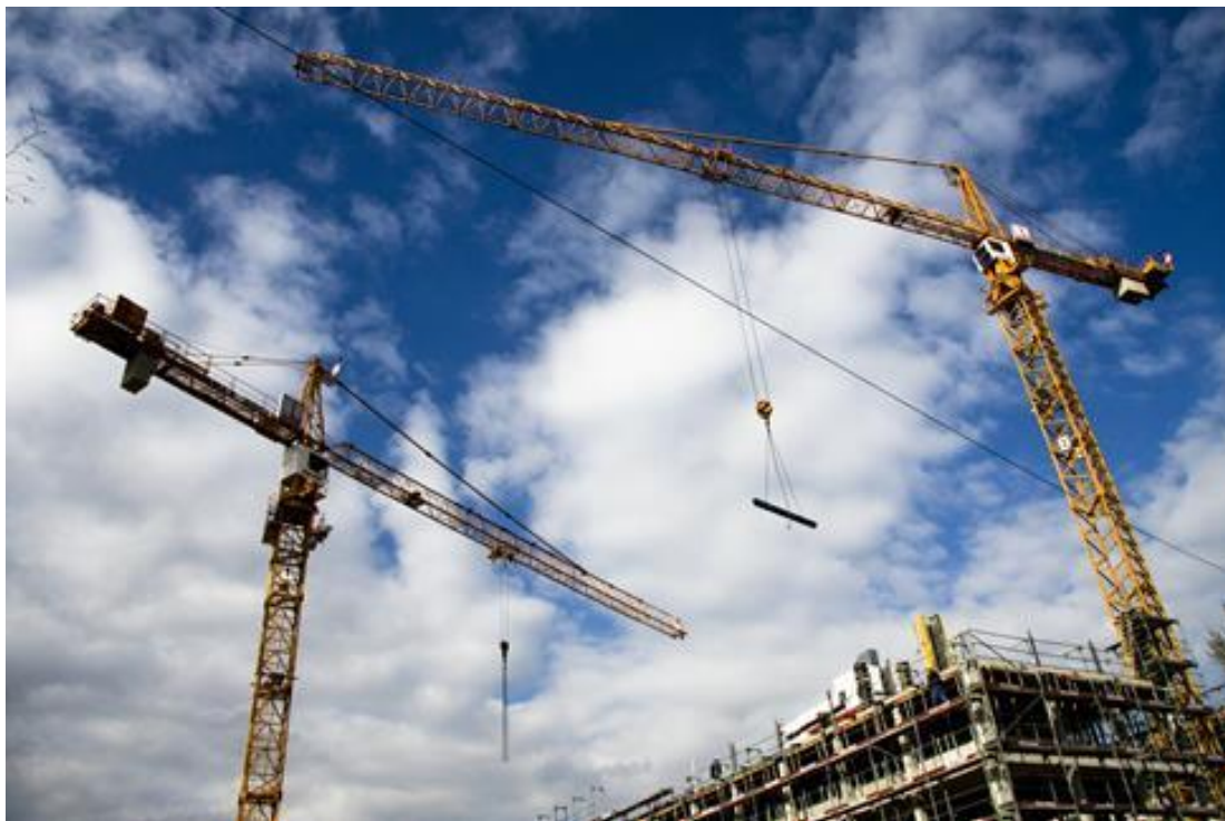
Figura 17: Grua em canteiro de obras.
