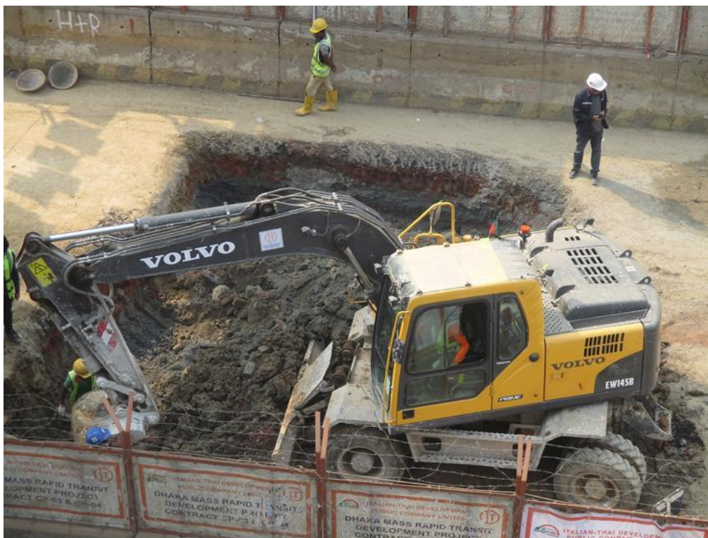
Figura 18: Escavação sendo iniciada em canteiro de obras
