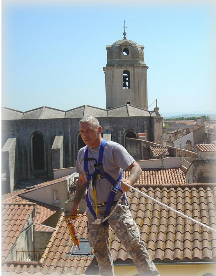
Figura 4: Trabalhador utilizando cinto de segurança tipo paraquedista segurando talabarte na mão
