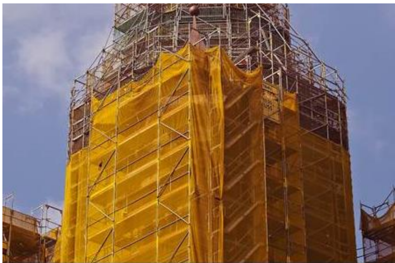
Figura 31: Telas de proteção contra projeção de materiais
