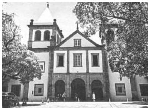
A) Mosteiro de São Bento (RJ)
