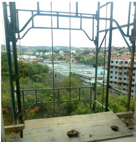
**Situação de grave e iminente risco 1:** Risco de queda de altura. Torre de elevador tracionado a cabo. A cabine do elevador não se encontra no pavimento e não existe nenhuma proteção que impeça o acesso do empregado ao vão da cabine, protegendo-o contra queda de altura. Deve ser instalada, em cada pavimento, uma cancela que ofereça proteção contra queda de altura quando a cabine do elevador não estiver na altura do pavimento. Nesta situação o elevador deve ser interditado.
