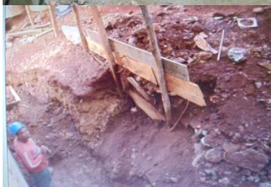
**Situação de grave e iminente risco 4:** Talude sem contenção adequada, em obra de construção civil: Risco de desmoronamento / soterramento: A obra deve ser **embargada**.
