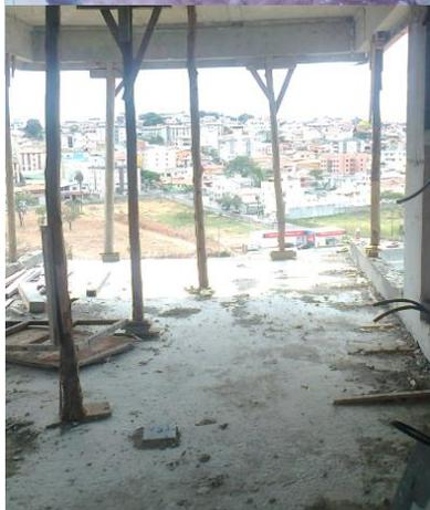
**Situação de grave e iminente risco 5:** Obra de edifício residencial sem proteção na periferia contra queda de altura, do tipo guarda corpo e rodapé, em todos os andares: A obra deve ser **embargada**. Lembrando que se o risco de queda de altura estiver presente em todos os andares, o embargo da obra deve ser **total**. Caso o risco exista apenas em alguns andares, é possível que o embargo seja parcial (considerando que não existirão outros riscos nos demais andares).
