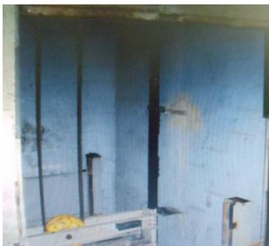
**Situação de grave e iminente risco 2:** Elevador de carga - Área de estoque de um supermercado: A porta do elevador de carga está aberta sem que a cabina esteja no nível do pavimento: risco de queda de altura. O elevador deve ser **interditado**.
