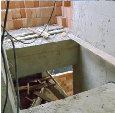
**Situação de grave e iminente risco 3:** Obra de construção de edifício residencial: Caixa do poço do elevador definitivo, sem fechamento provisório, em todos os pavimentos: risco de queda de altura. A obra deve ser **embargada**.
