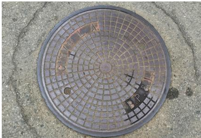
Figura 64: As tampas de ferro fundido nas ruas são a porta de entrada para o interior do poço de visita
