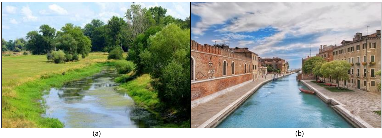
Figura 67: Intervenção na seção de canais: a) canal natural; b) canal com seção transversal alterada e revestimento de concreto
