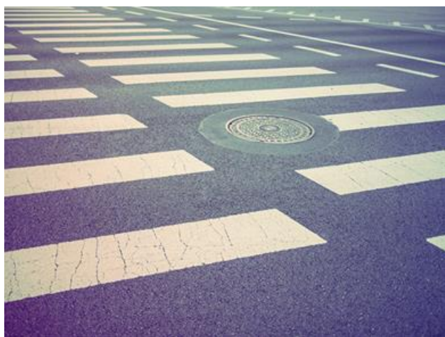
Figura 64: As tampas de ferro fundido nas ruas são a porta de entrada para o interior do poço de visita
