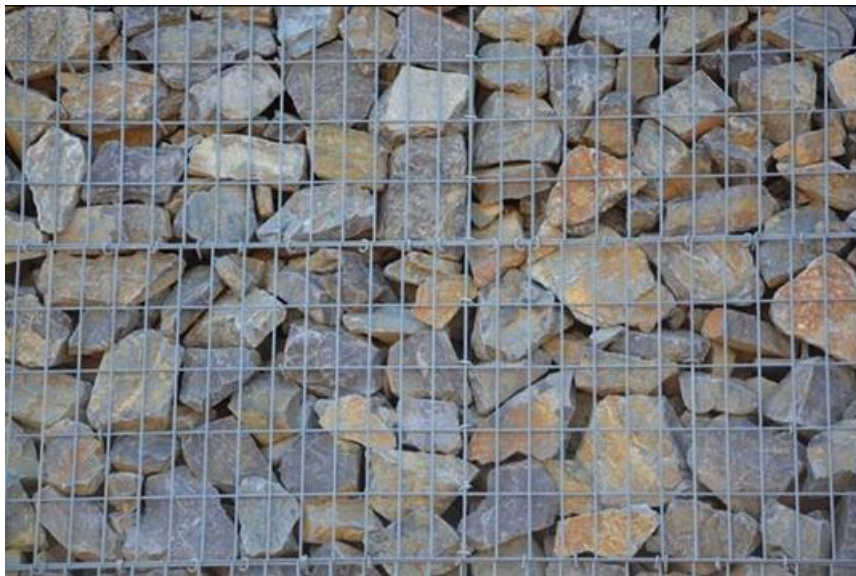
Figura 76: Revestimento de gabião: Detalhe da malha metálica da gaiola preenchida com rochas britadas.
