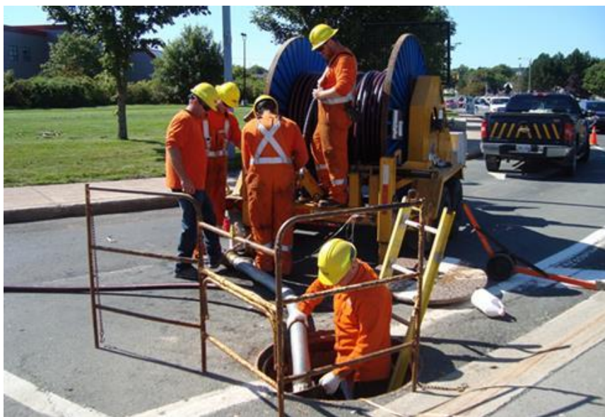
Figura 63: Operários utilizando um poço de visita para realizar manutenção na rede de drenagem pluvial
