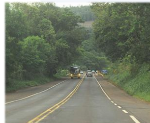
RODOVIA DE PISTA SIMPLES
